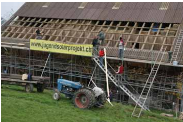
Bau einer Kollektoranlage
