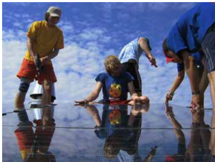
Montage von Solarpanels
